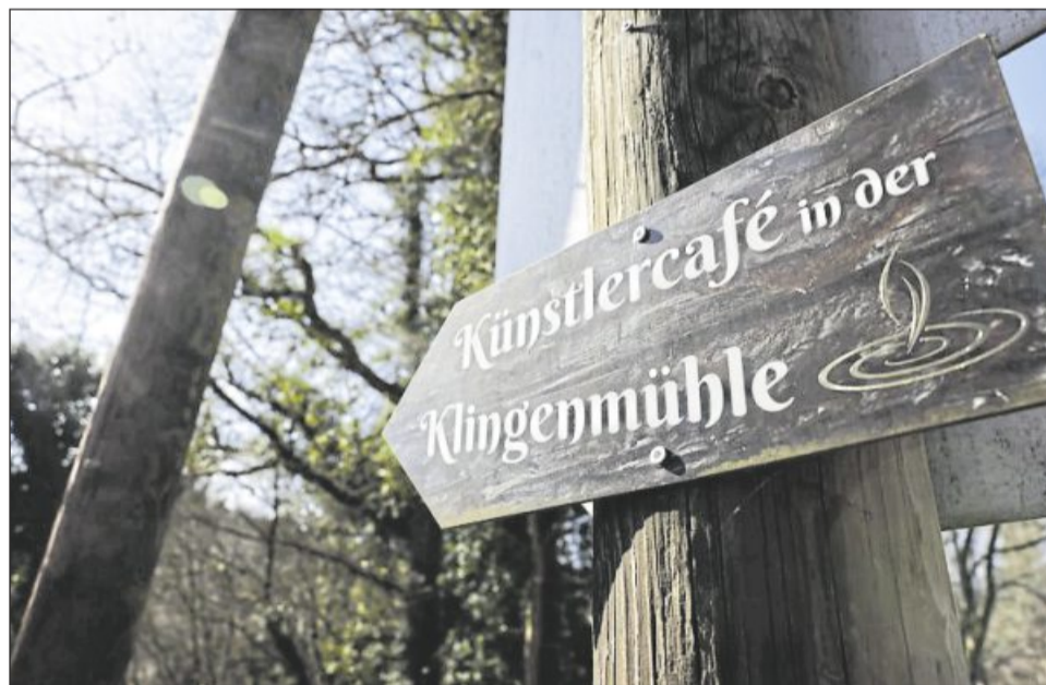
Wie steht es eigentlich um das Ausflugsziel Klingenmühle? Das historische Gebäude mit Künstlercafé war im Juni 2024 durch einen Hangrutsch stark beschädigt worden. Foto: Benjamin Buettner
